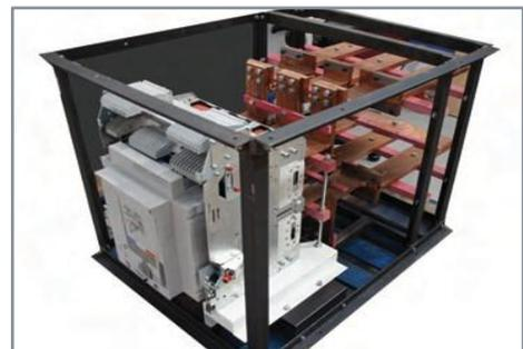
As interligações dos componentes em cobre são projetadas utilizando softwares específicos de avaliação de curto-circuitos. Os barramentos de ligação e respetivos suportes podem ser testados de acordo com a norma IEC 61439 (teste de esforço eletrodinâmico das barras).
