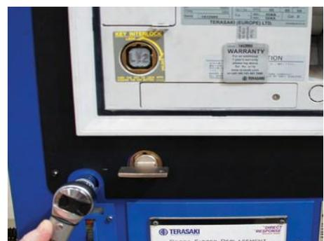
A funcionalidade de extração e os encravamentos de segurança dos equipamentos originais serão preservados e melhorados. Caso seja pretendido os equipamentos fixos podem ser alterados para a função extraível.
