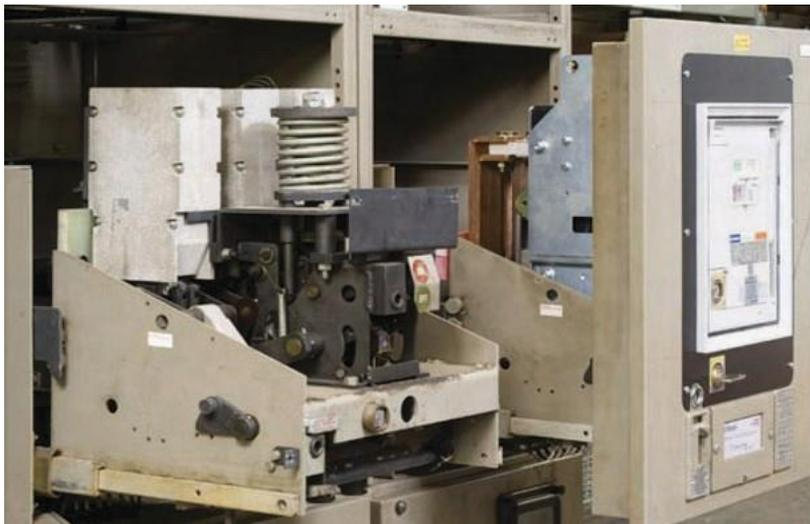
Retrofit refere-se à melhoria e implementação de novas tecnologias nos sistemas mais antigos. As soluções de retrofit com ACBs podem substituir equipamentos de corte e proteção antigos e inseguros.
